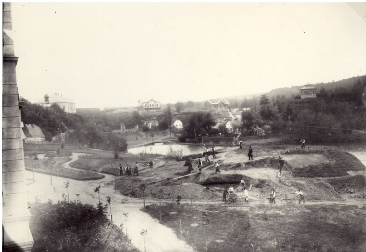
Budování parku (foto soukromý archiv Michala Kampa)
