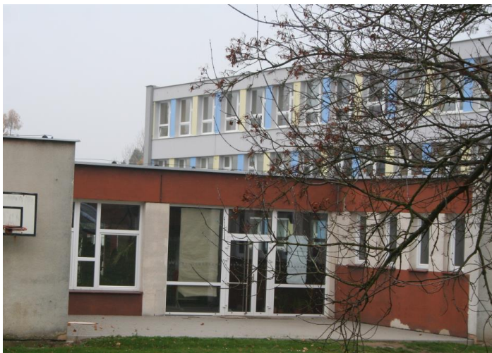
Obr. 30: ZŠ Wolkerova 2941, Havlíčkův Brod
