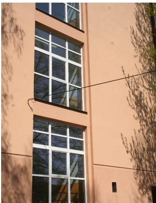
Obr. 31: V Sadech 560, Havlíčkův Brod
