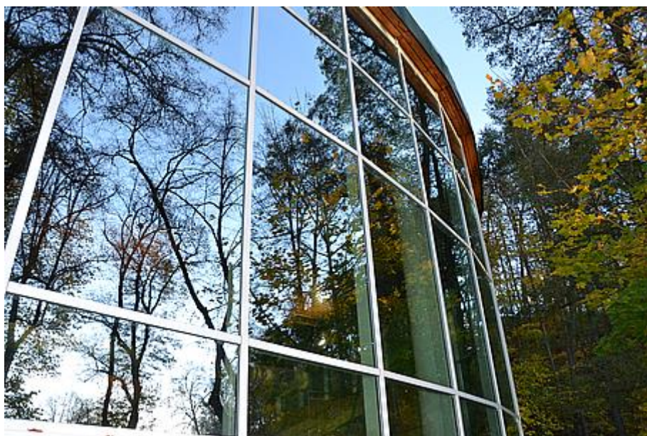
Obr. 2: Reflexní skla v blízkosti zeleně tvoří pro ptáky velmi nebezpečné prostředí (plavecký bazén v Havlíčkově Brodě).
