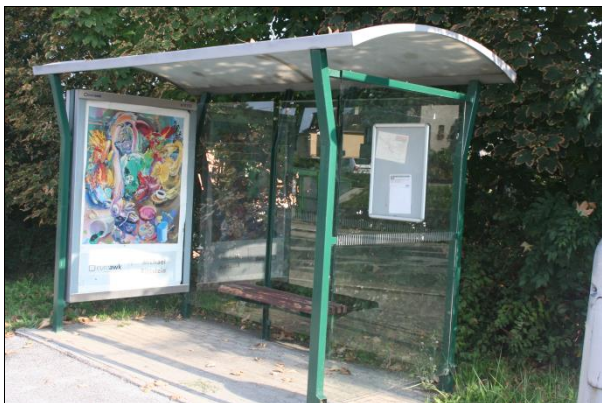
Havlíčkův Brod, Vysočany blízkost husté vegetace Nebezpečná zastávka
