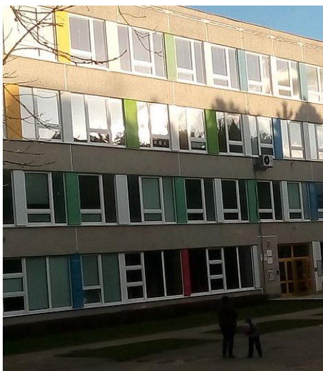
Obr. 31: Nuselská 3240, Havlíčkův Brod
