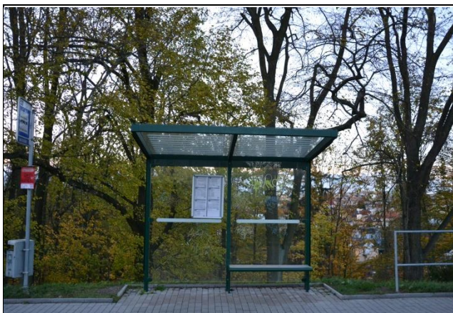
Havlíčkův Brod, Nad Kalváří v těsné blízkosti rozsáhlého porostu parku nebezpečná zastávka, ale v současnosti posprejována (snížena rizikovitost)
