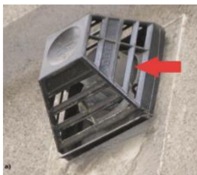
Obr. 6: Výústění plynových topidel. Mřížemi netopýři snadno prolezou do vývodové roury a do topného tělesa.
