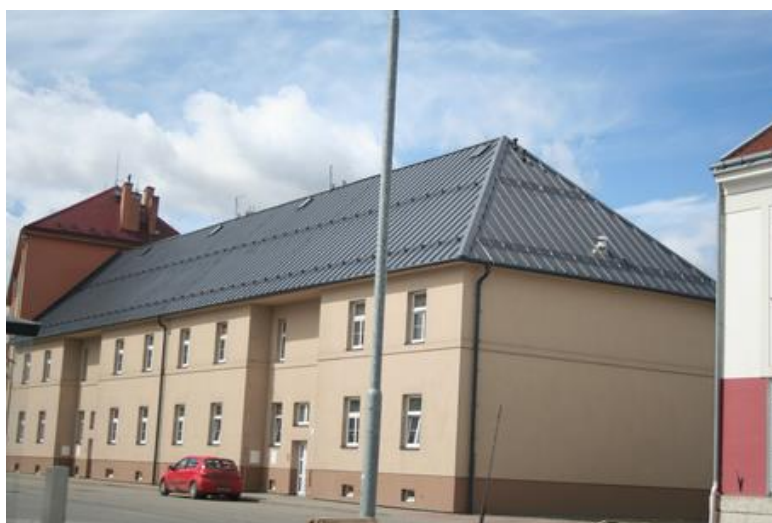
Obr. 7: Zrekonstruovaný dům 5. května 310 a 311, původně zde hnízdilo 6 párů kavek a nyní 0.
