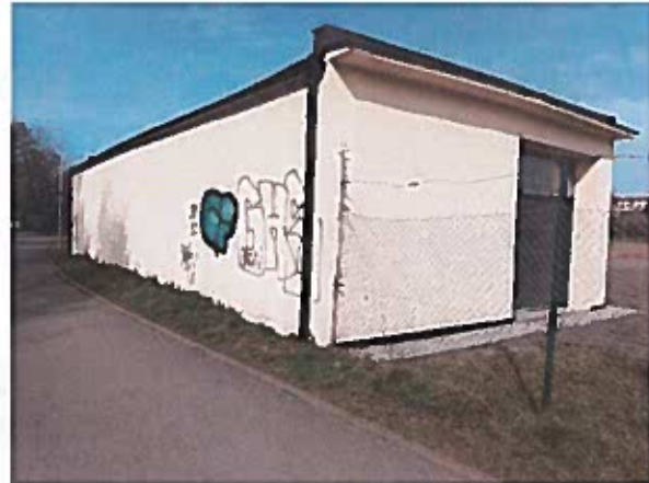
Jižní zeď skladu u cyklostezky Na Losích
