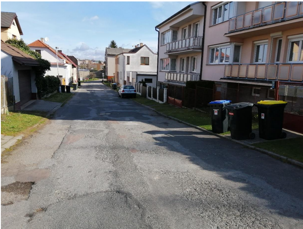
ulice Údolní před svozem
