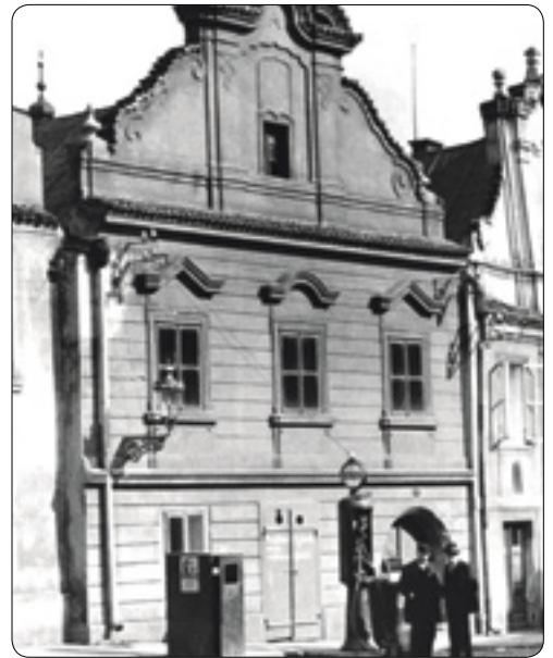
Jedna z dalších benzinových čerpacích stanic byla zřízena v Horní ulici pod bývalým hostincem U Karla IV.
