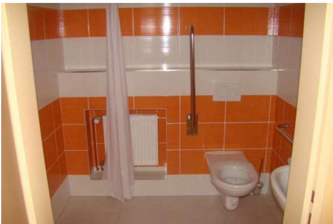
Prostory koupelna a WC zrekonstruovaného dvoulůžkového pokoj
