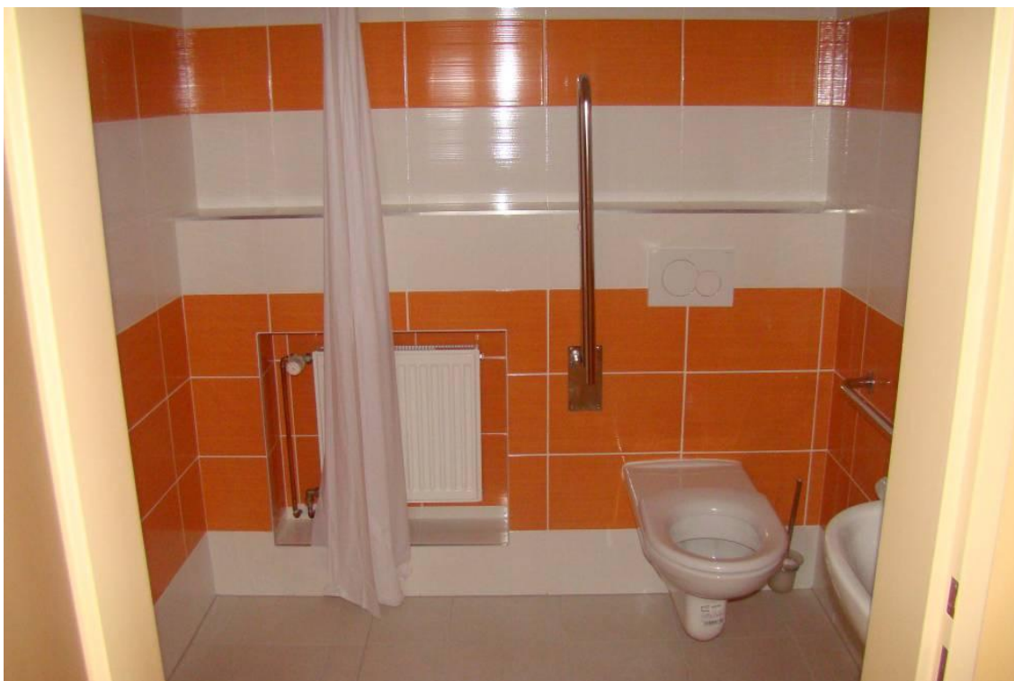
Prostory koupelna a WC zrekonstruovaného dvoulůžkového pokoj
