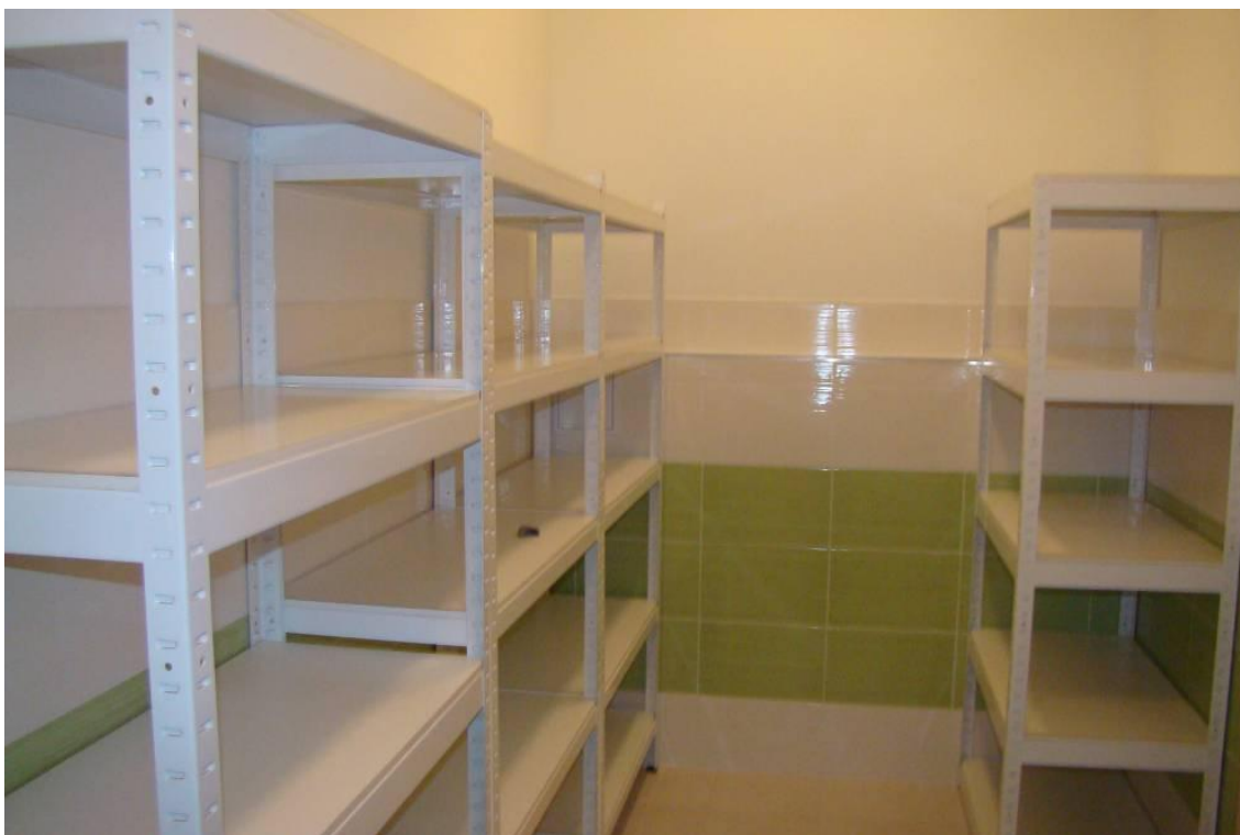
Prostory rekonstruovaného skladu patří k oddělení se zvláštním režimem
