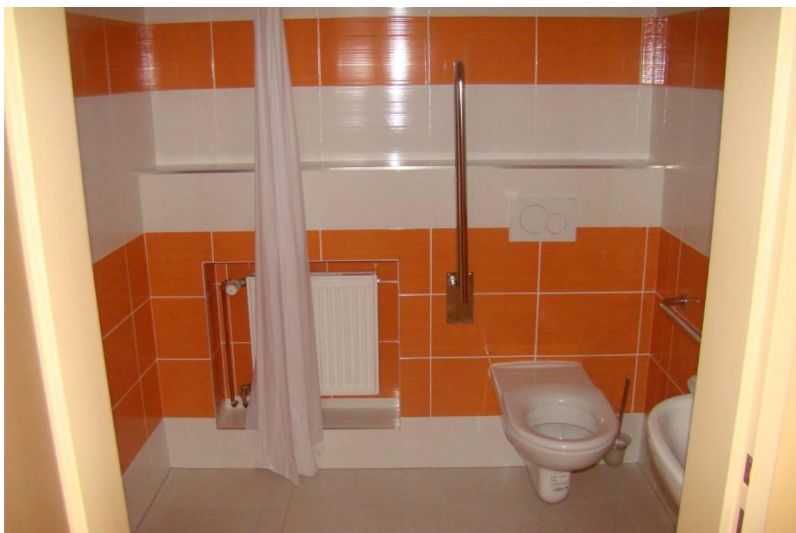
Prostory koupelna a WC zrekonstruovaného dvoulůžkového pokoje
