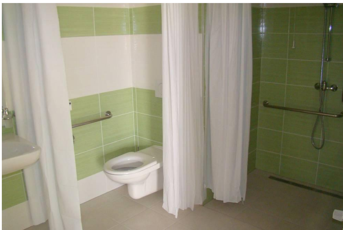
Prostory koupelna a WC zrekonstruovaného dvoulůžkového pokoje
