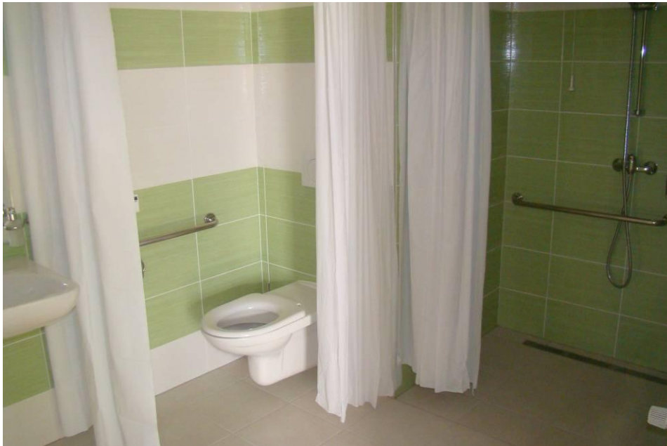
Prostory koupelna a WC zrekonstruovaného dvoulůžkového pokoje.
