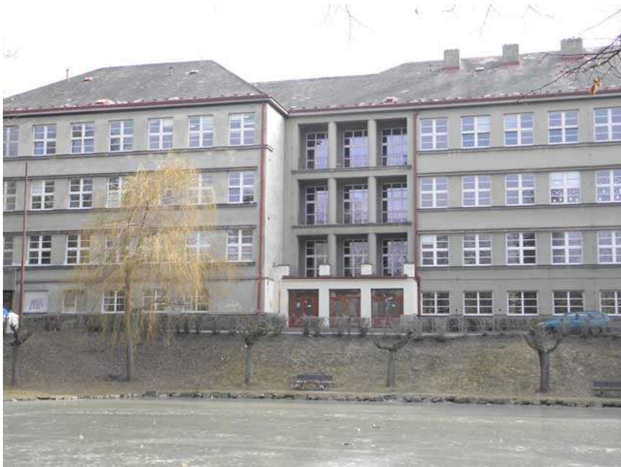
Objekt ZŠ V Sadech po zateplení (výměně oken)
