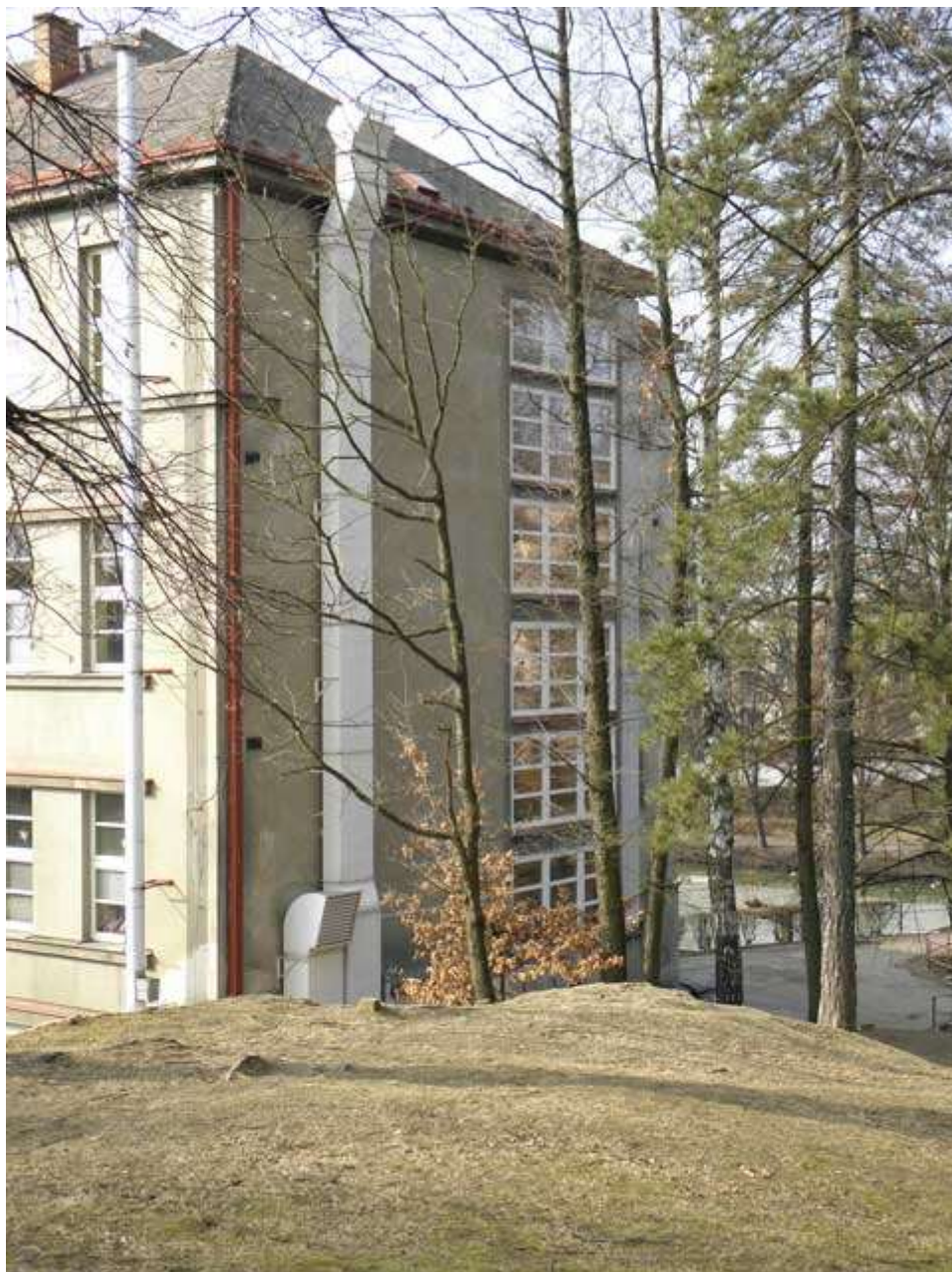
Objekt ZŠ V Sadech po zateplení (výměně oken)
