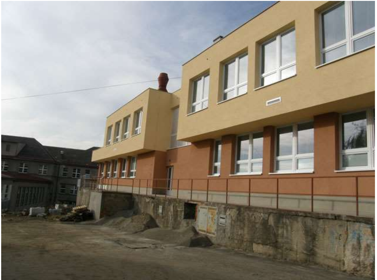
Objekt ŠJ Prokopa Holého po zateplení
