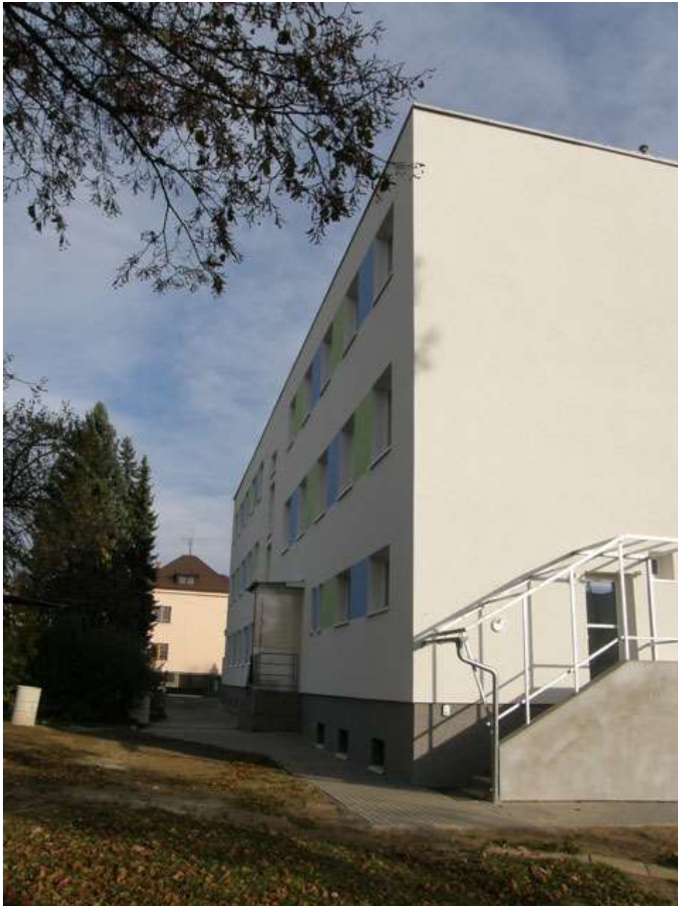
Objekt MŠ Zahradnického po zateplení
