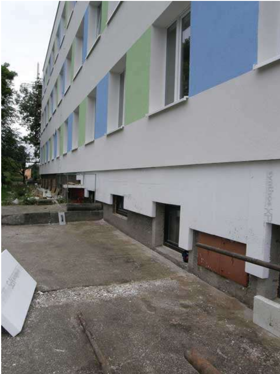
Objekt MŠ Zahradnického po zateplení
