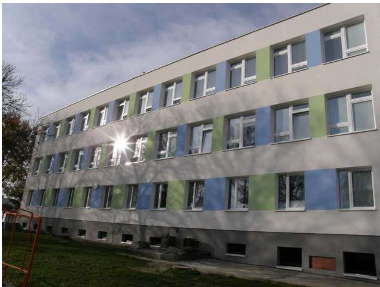
Objekt MŠ Zahradnického po zateplení
