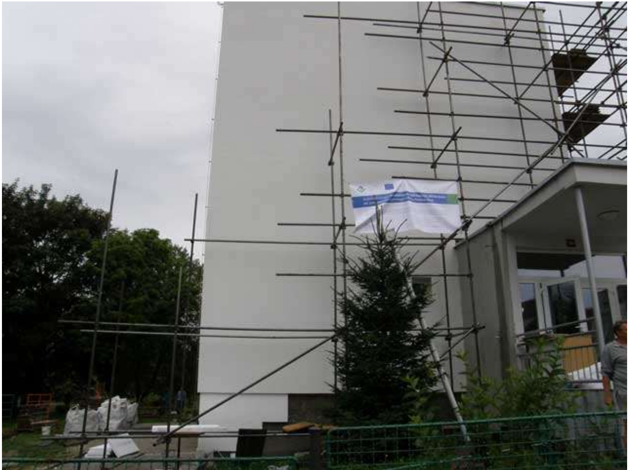
Dokončování stavebních prací MŠ Zahradnického
