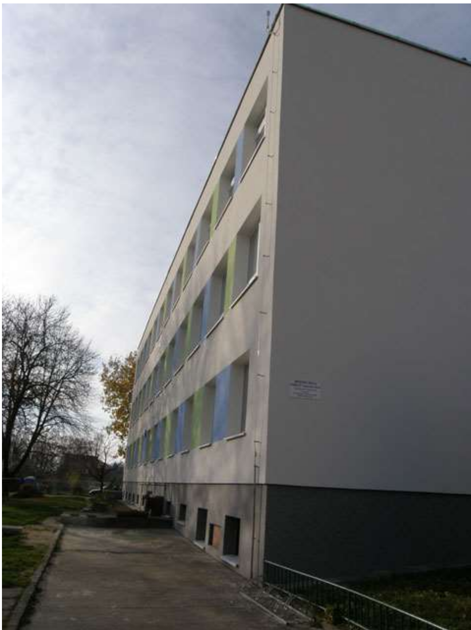
Objekt MŠ Zahradnického po zateplení
