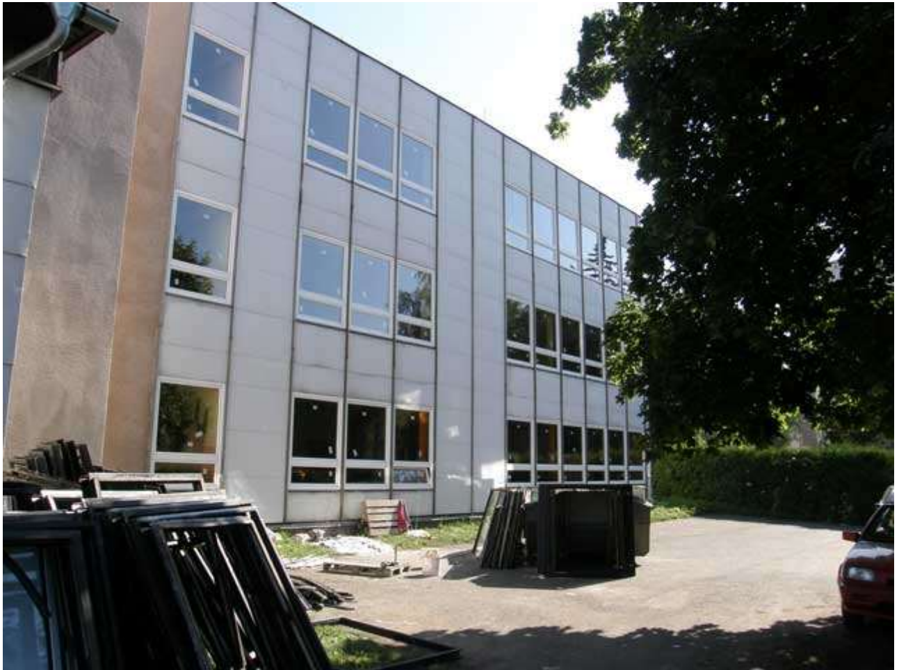
Stavební práce na zateplování MŠ Prokopa Holého
