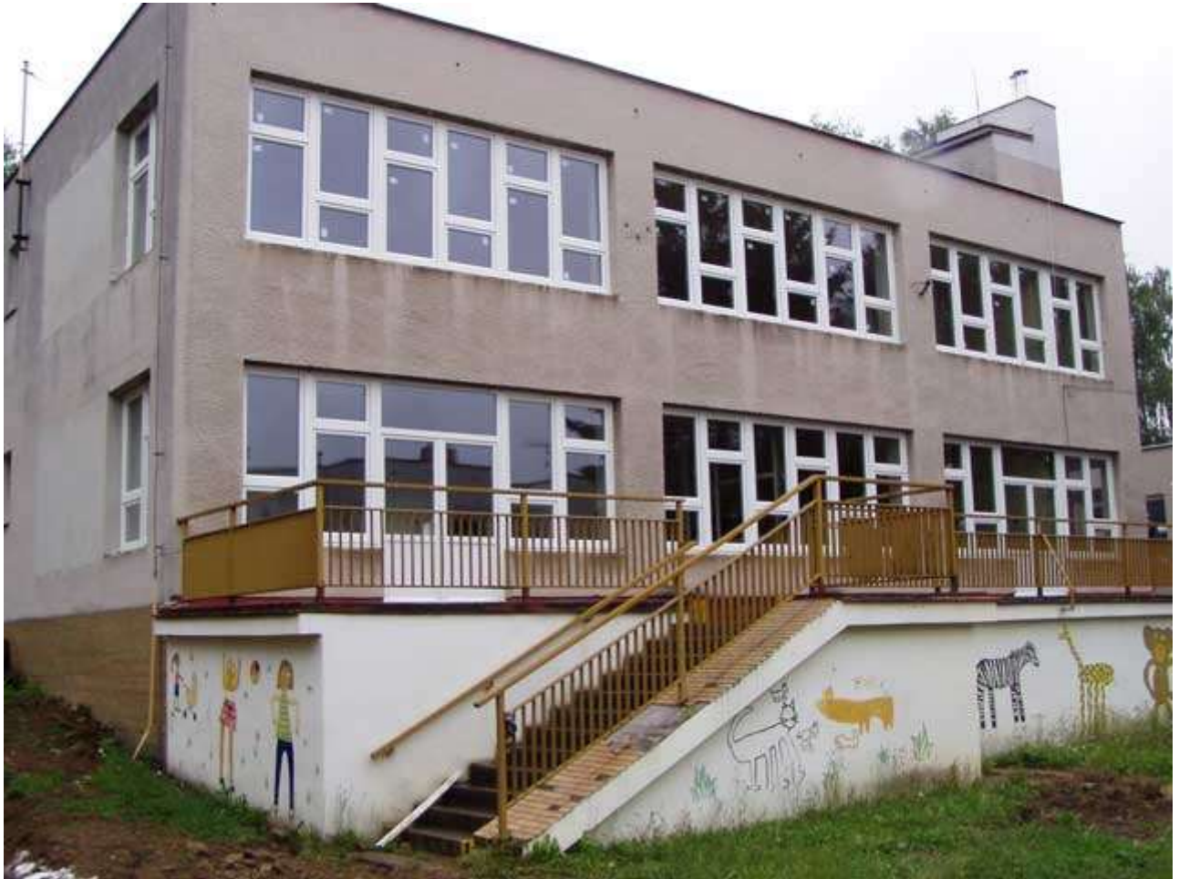
Objekt MŠ Na Svahu po výměně oken
