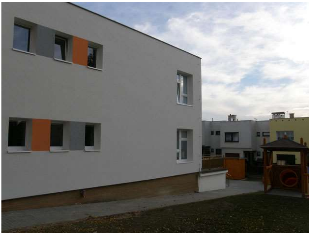
Objekt MŠ Na Svahu po zateplení
