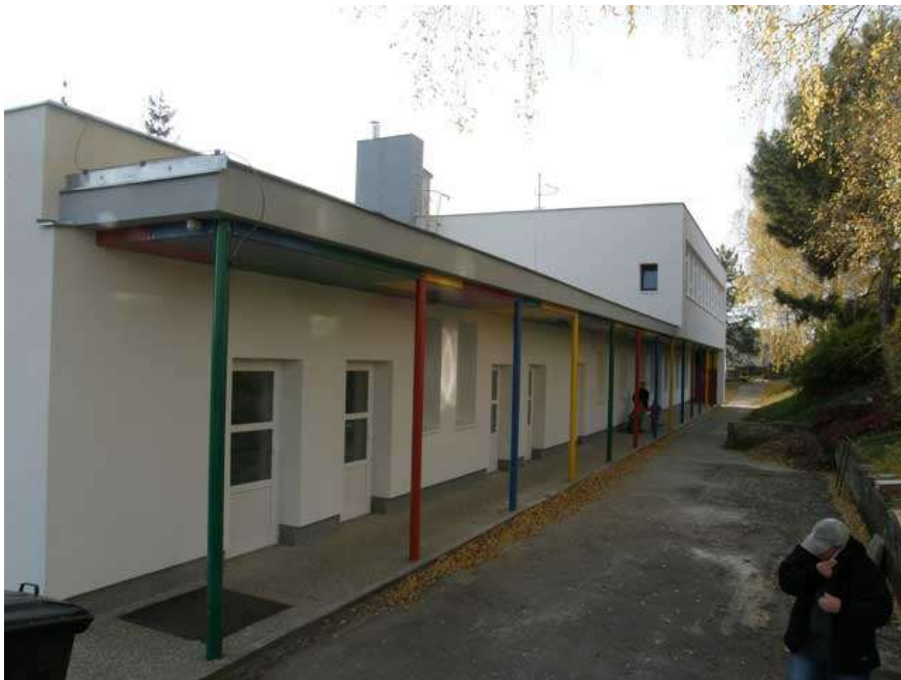
Objekt MŠ Na Svahu po zateplení
