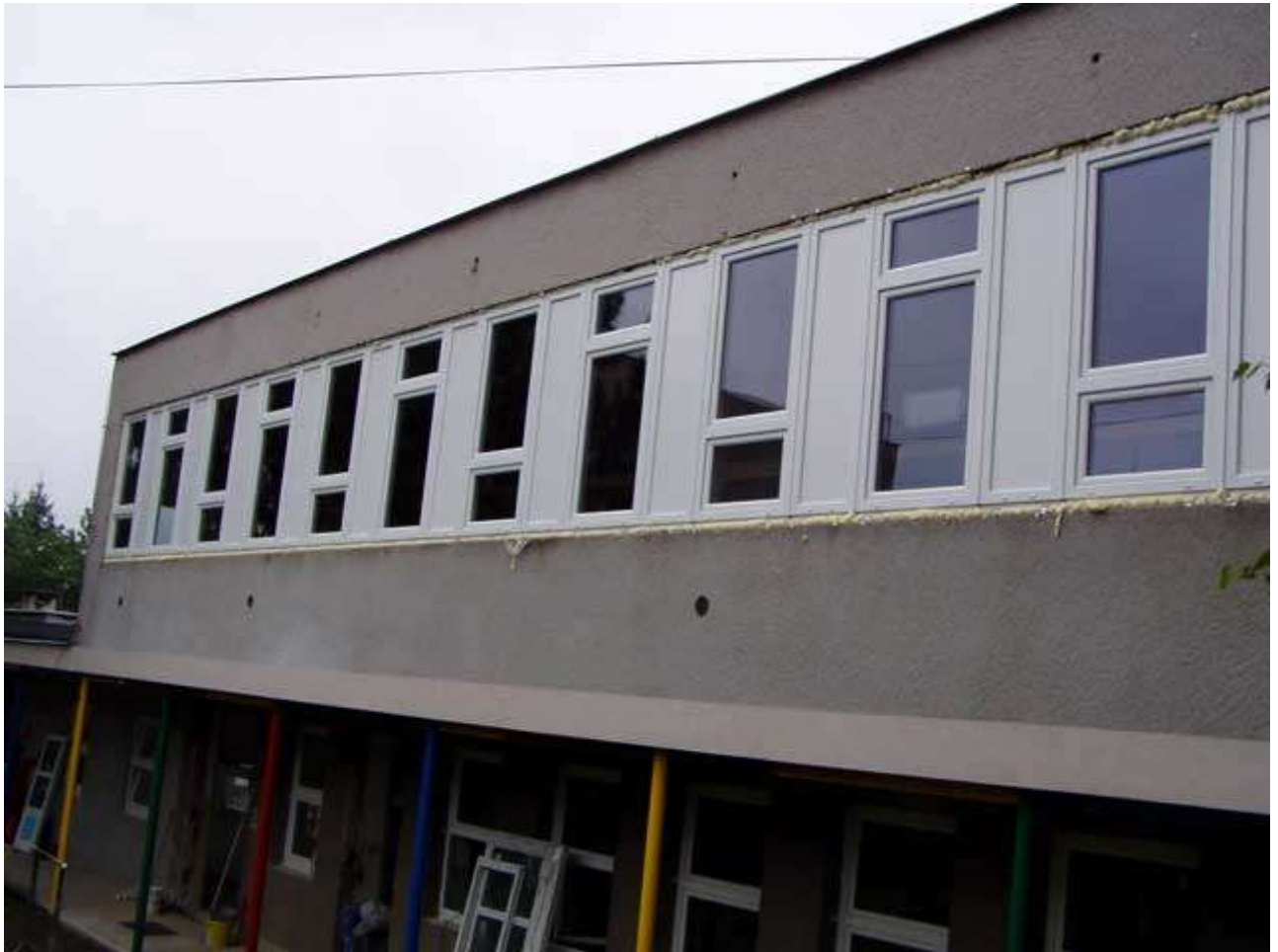
Objekt MŠ Na Svahu po výměně oken
