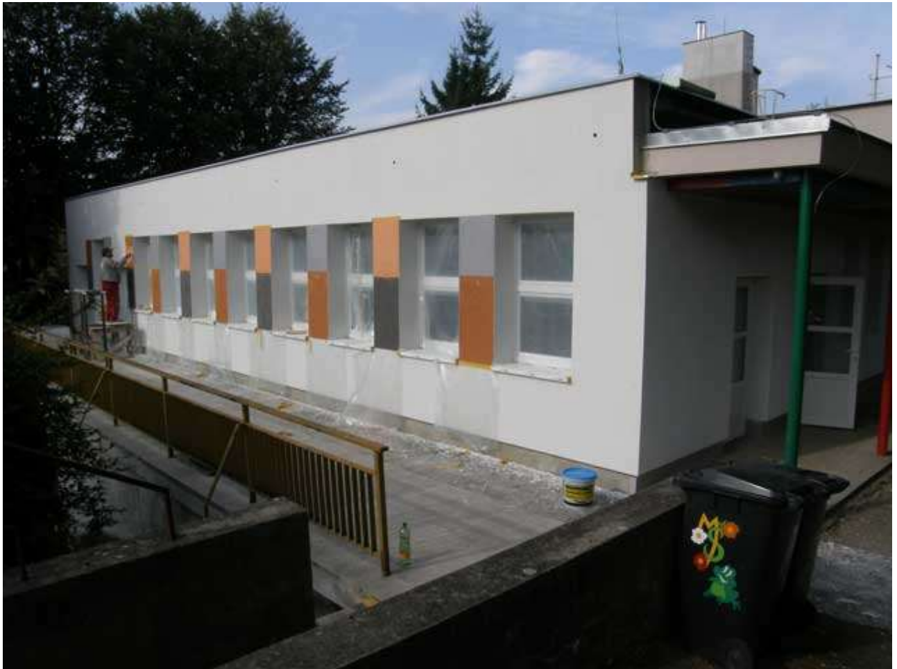
Stavební práce na objektu MŠ Na Svahu
