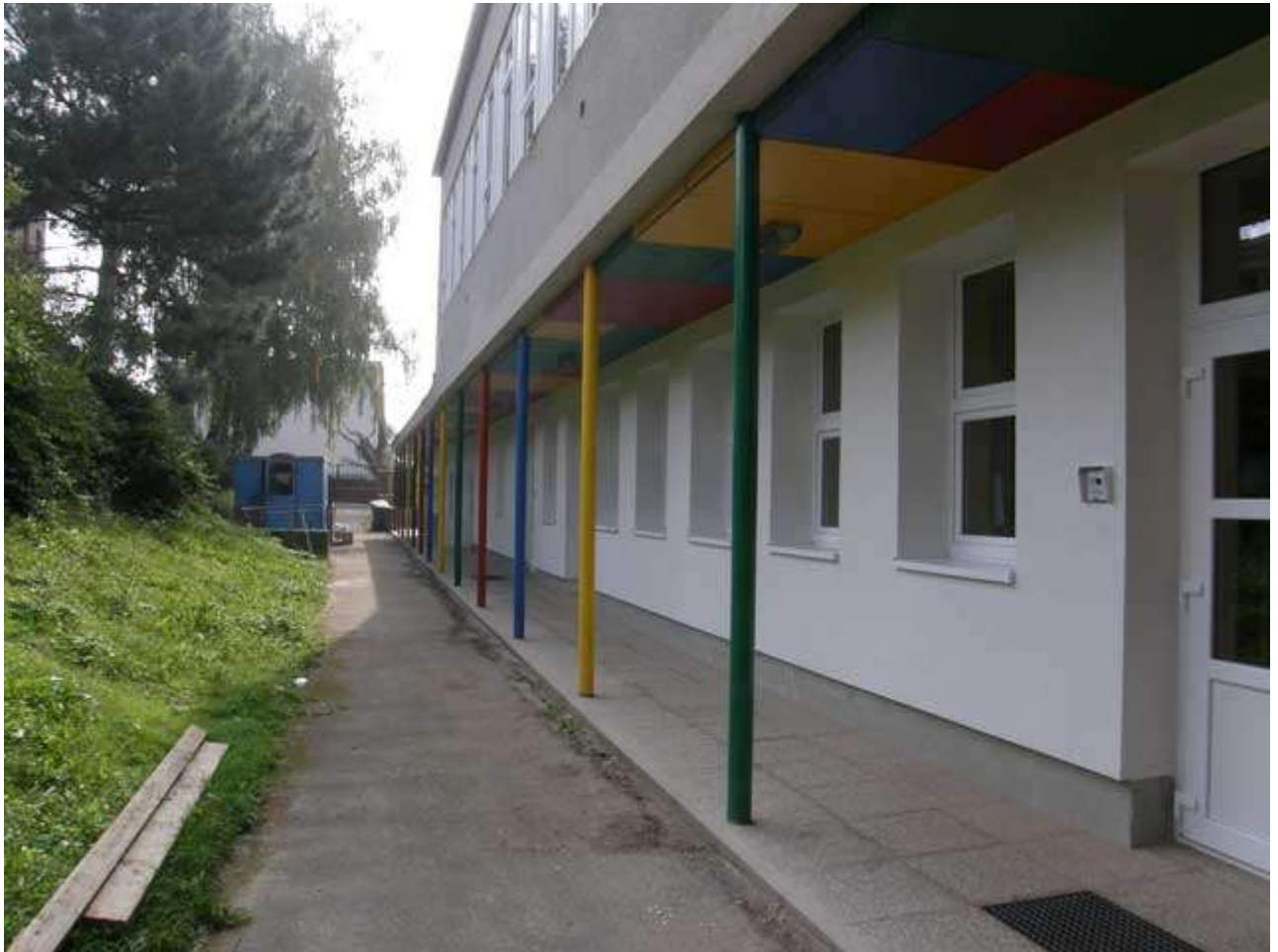
Objekt MŠ Na Svahu po zateplení
