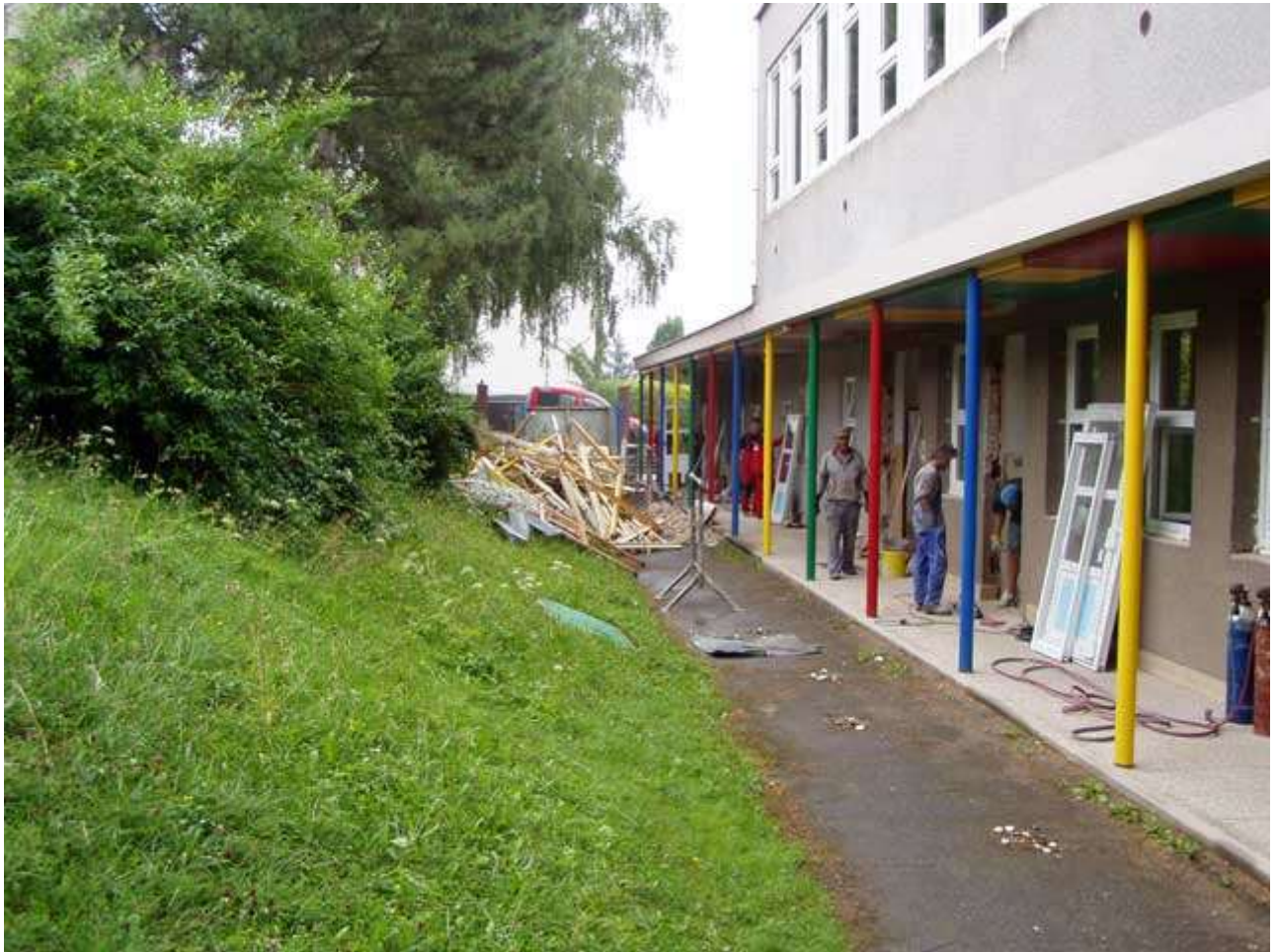
Stavební práce na objektu MŠ Na Svahu
