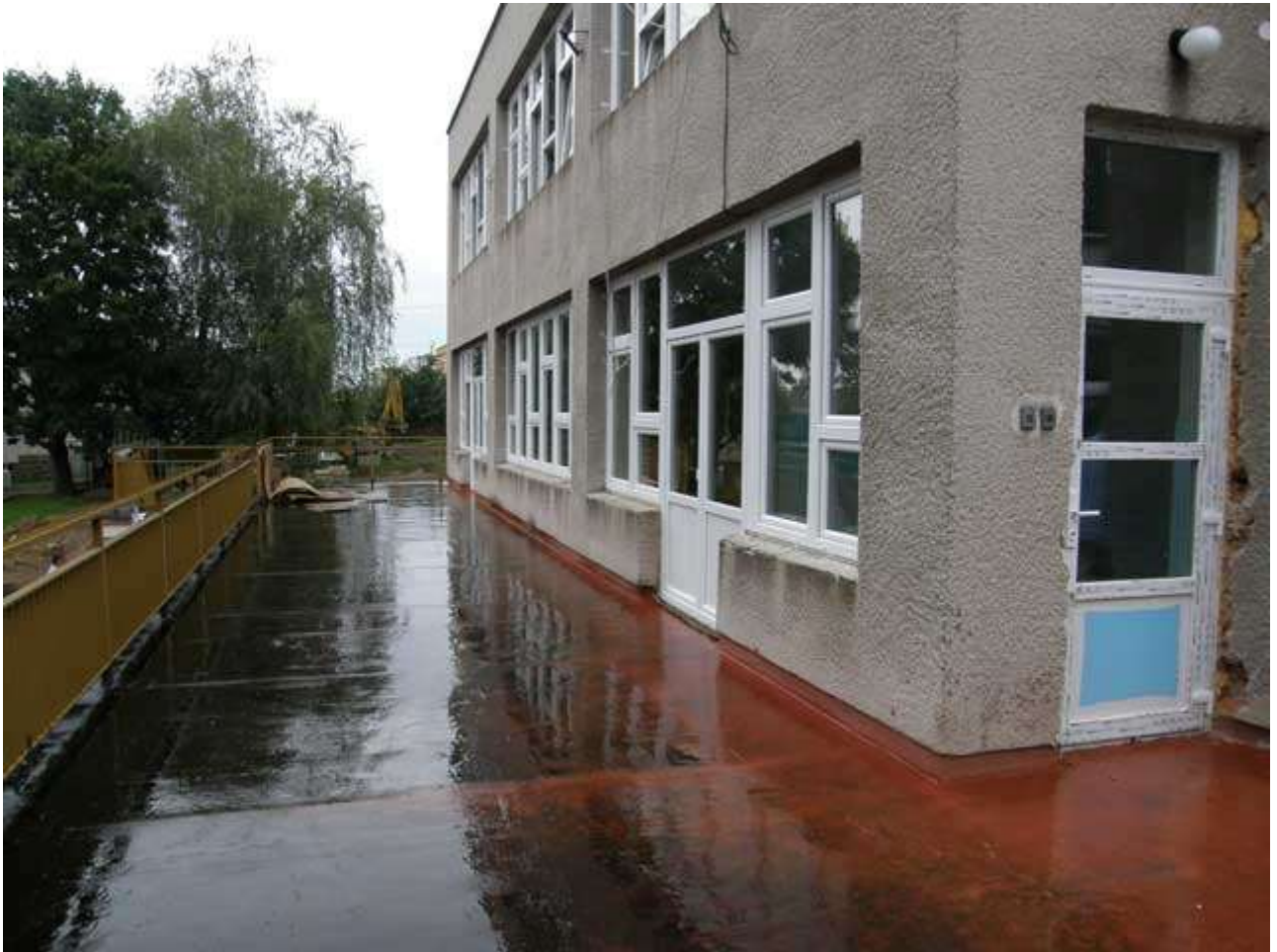
Objekt MŠ Na Svahu po výměně oken
