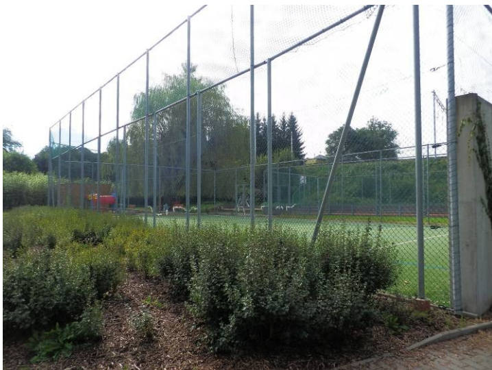
Pohled na oplocená sportovní hřiště směrem od chodníku u Jihlavská ulice.
