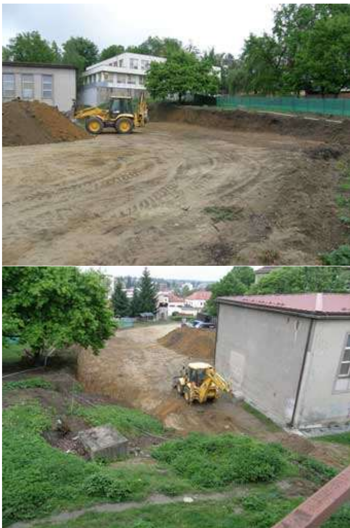
27. 3. 2009 - Předání staveniště zhotoviteli – zahájení fyzické realizace projektu
