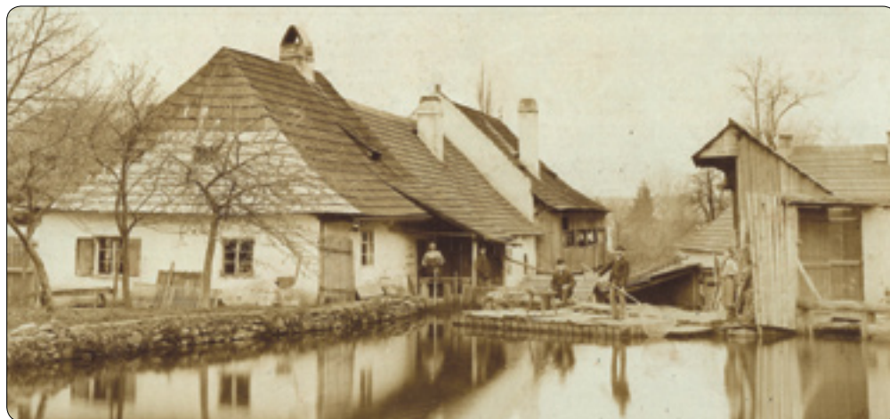
Malý mlýn s nádrží Valšičkou, který koupil rybářský spolek v roce 1915. Značně sešlé stavení muselo být zbouráno v roce 1985. Na jeho místě si členové spolku postavili do roku 1988 vlastními silami novou rybárnu, kde sídlí dodnes. (Foto ze sbírek SOKa Havlíčkův Brod)
