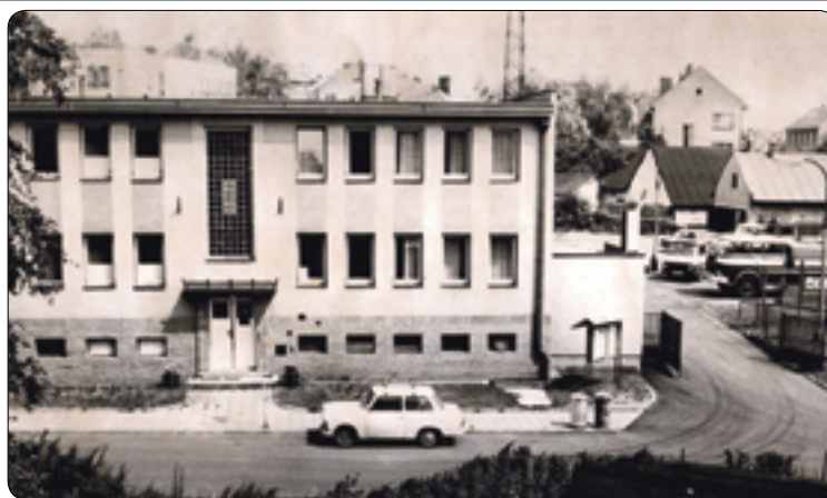
Původní vzhled hlavní budovy požární zbrojnice dokončené v roce 1968. (foto ze sbírek SOka Havlíčkův Brod)
