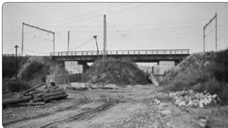
Zbudování podjezdu pod železniční tratí na Prahu patřilo k obtížnějším úsekům severojižního průtahu městem. Celá přeložka byla dána do provozu v roce 1969. (Foto Jan Jelínek)
