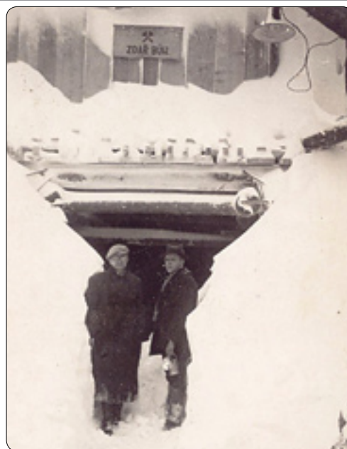
Zahájení stavby tunelu. Fotoarchiv Muzea Vysočiny Havlíčkův Brod
