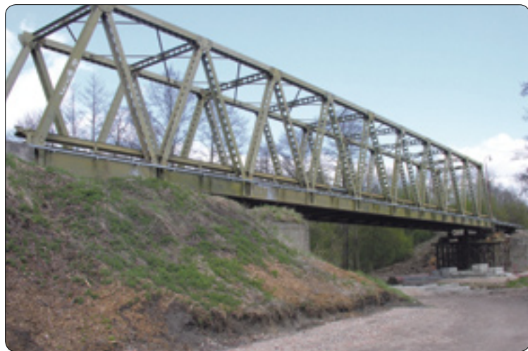
Provizorní most přes Sázavu na pardubické trati na tomto snímku, který nahradil ve druhé polovině osmdesátých let minulého století ten původní, již také patří do minulosti. Na jeho místě byla letos usazena nová konstrukce definitivního přemostění.
