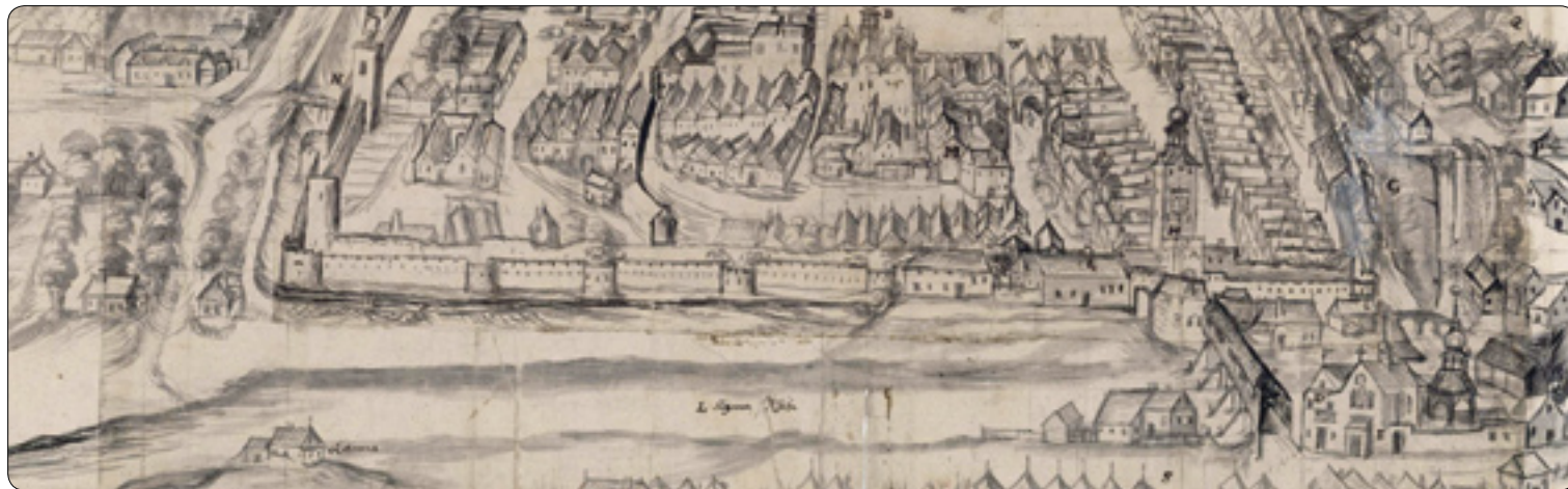
Obydlí brodského kata stálo osamocené na levém břehu Sázavy. Na výřezu ze známého vyobrazení města od Beckovského z roku 1705 je to bezpochyby stavení v levém dolním rohu.
