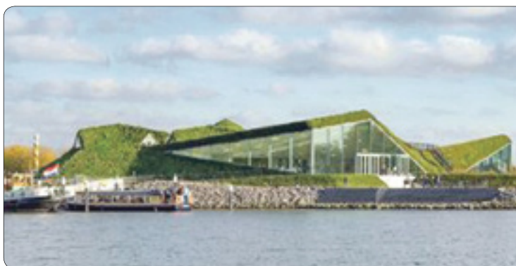
Zapuštění stavby na severozápadní straně a střecha pokrytá travním porostem... foto: Ronald Tilleman
