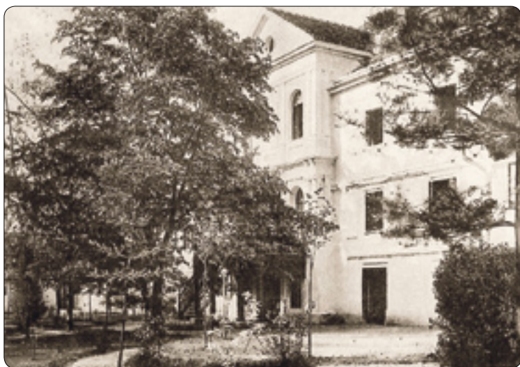
Pohled na lázně z dokonale upraveného parku, který lákal k procházkám.
