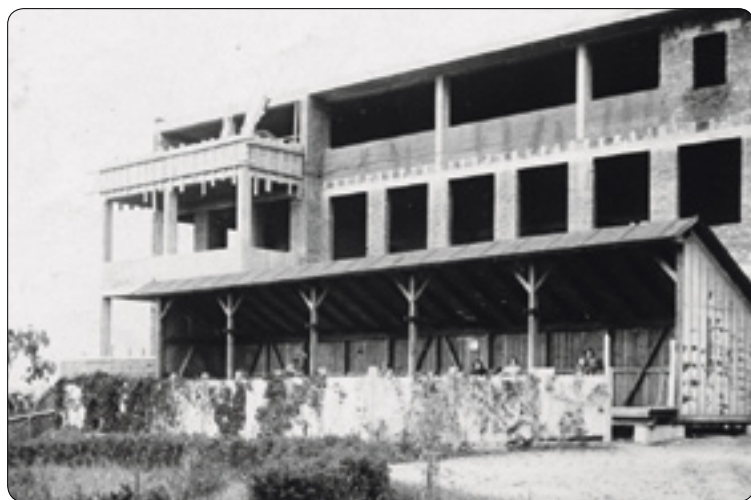
Pavilon pro léčbu chirurgické tuberkulózy ve výstavbě.
