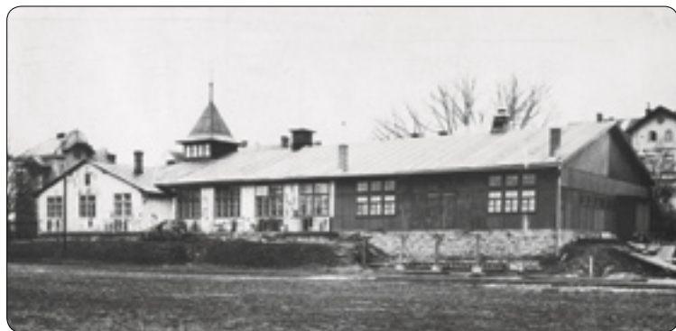
Sokolovna po rozšíření v r. 1947. Přístavba, ke které posloužil likvidovaný dřevěný barák ze Šlapanova, na snímku patrná.
