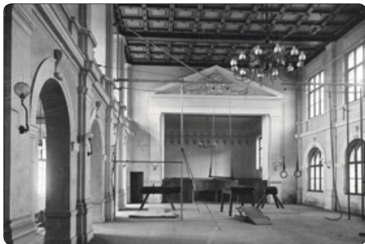
Velký sál sokolovny byl vybaven tělocvičným nářadím, velký lustr i nástěnná svítidla byla původně plynová.
