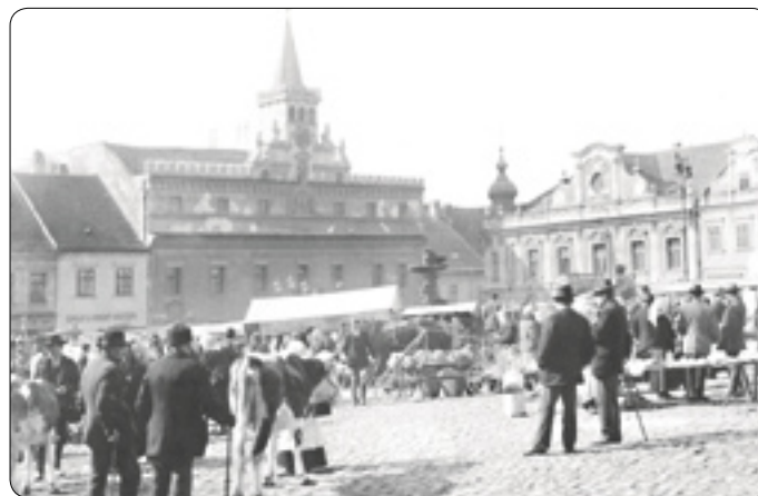
Trh na Havlíčkově náměstí po I. světové válce.
