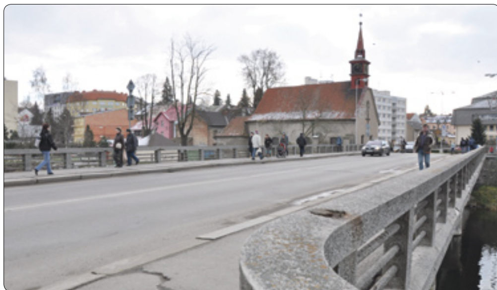
Investiční akce se skládá ze dvou staveb. První z nich je oprava mostu.
