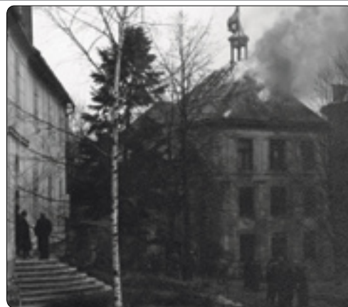
Osud Barborky se začal naplňovat po dalších více jak padesáti letech. Když ji 13. 3. 1943 zachvátil požár a shořela střecha i s krovky, byla poté ještě provizorně zakryta. Neprospěly jí ani výbuchy spojeneckých bomb 15. 11. 1944 v její blízkosti, které jí otřáslly v základech a po nichž zůstala stejně jako sousední budova bez okenních skel. Po osvobození byla zchátralá budova v r. 1945 zbourána.
