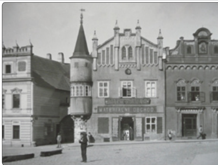
Pohled na Havlíčkův dům z r. 1890 po novogotických úpravách průčelí v 60. letech, před další úpravou fasády v r. 1893
