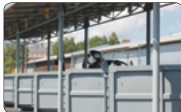
Modernizovaný sběrný dvůr TS (str. 4)
