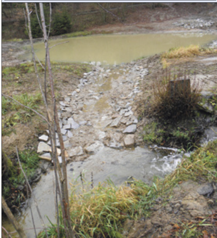
Pohled na nově vybudovanou pravobřežní tůň a propojovací koryto v úseku mezi Zádušním a Pfaffendorfským rybníkem
