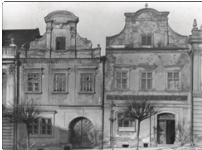
Stav obou domů čp. 56 a 55 v r. 1920 nebyl utěšený a bylo třeba stejně provést alespoň nejnútnejší stavební opravy, zvl. v domě čp. 56, v němž bylo v letech 1911–21 městské muzeum
