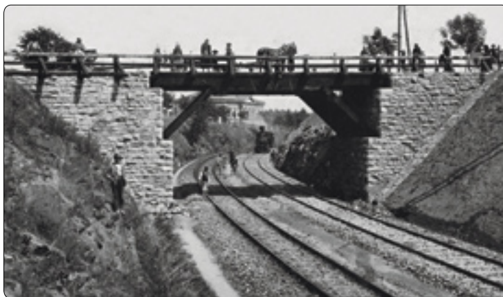
Nově dostavěná lokální dráha do Humpolce (kolej vpravo) v r. 1905 u tzv. černého mostu. Trať do Kolína byla až do konce 30. let 20. století jednokolejná.
