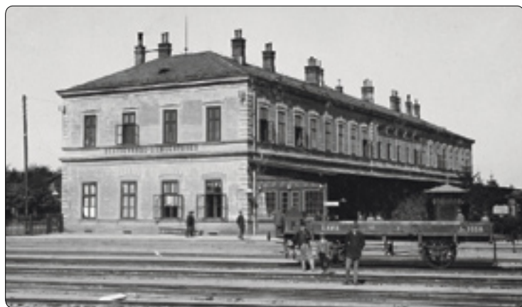
Nádražní budova sloužila svému účelu až do r. 1981, kdy byla zbourána. Stav kolem r. 1905.
