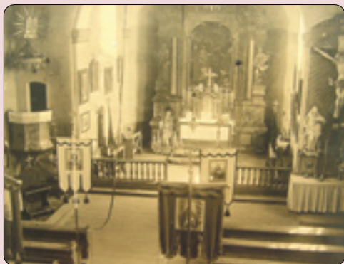
Interiér kostela v r. 1914 (SOKA Havlíčkův Brod)
