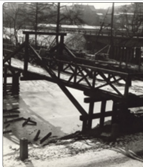
Likvidace dřevěné lávky (postavena v r. 1945) v zimě 1959/60. V pozadí nově vybudovaný železobetonový most u Rica.
