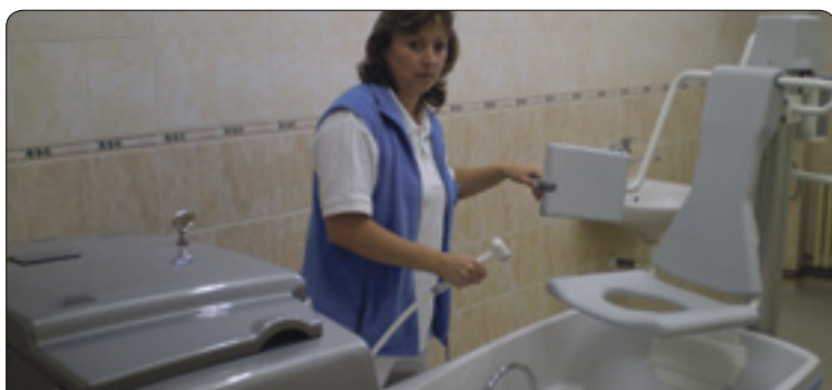
Klienti pečovatelské služby Na Výšině od listopadu mohou využívat nově zrekonstruované středisko osobní hygieny. Chloubou zařízení je výškově polohovatelná vana, která zajistí komfort jak pro klienty, tak personál. Sociální služby města
