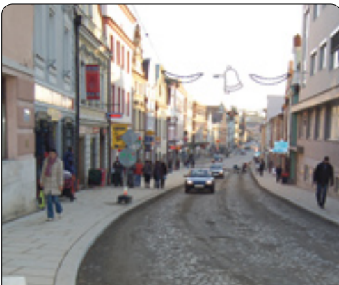
První etapu revitalizace Havlíčkova náměstí dokončila havlíčkobrodská radnice koncem listopadu a na zimu stavební práce přerušila. Komplettní rekonstrukcí prošla Dolní ulice.
