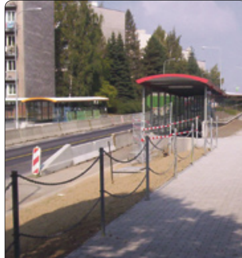
Masarykovu ulici v jednom z velmi kritických míst je možné bezpečně přecházet novým podchodem.
