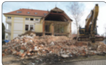
Začala přestavba infekčního oddělení nemocnice (str. 4)
