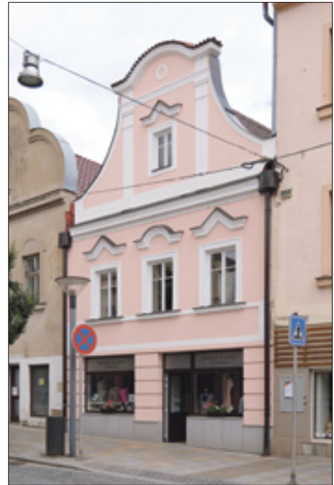
Dům č.p. 151, Dolní ulice, obnova fasády, Program regenerace MPZ 2020
