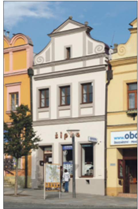
Šipka, Havlíčkově nám., obnova fasády, Program regenerace MPZ 2022
